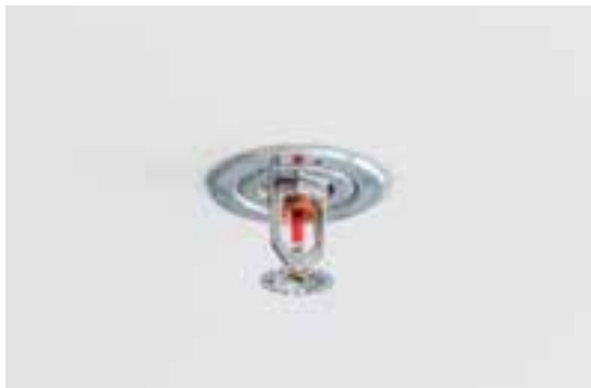
Sprinkler i tak
