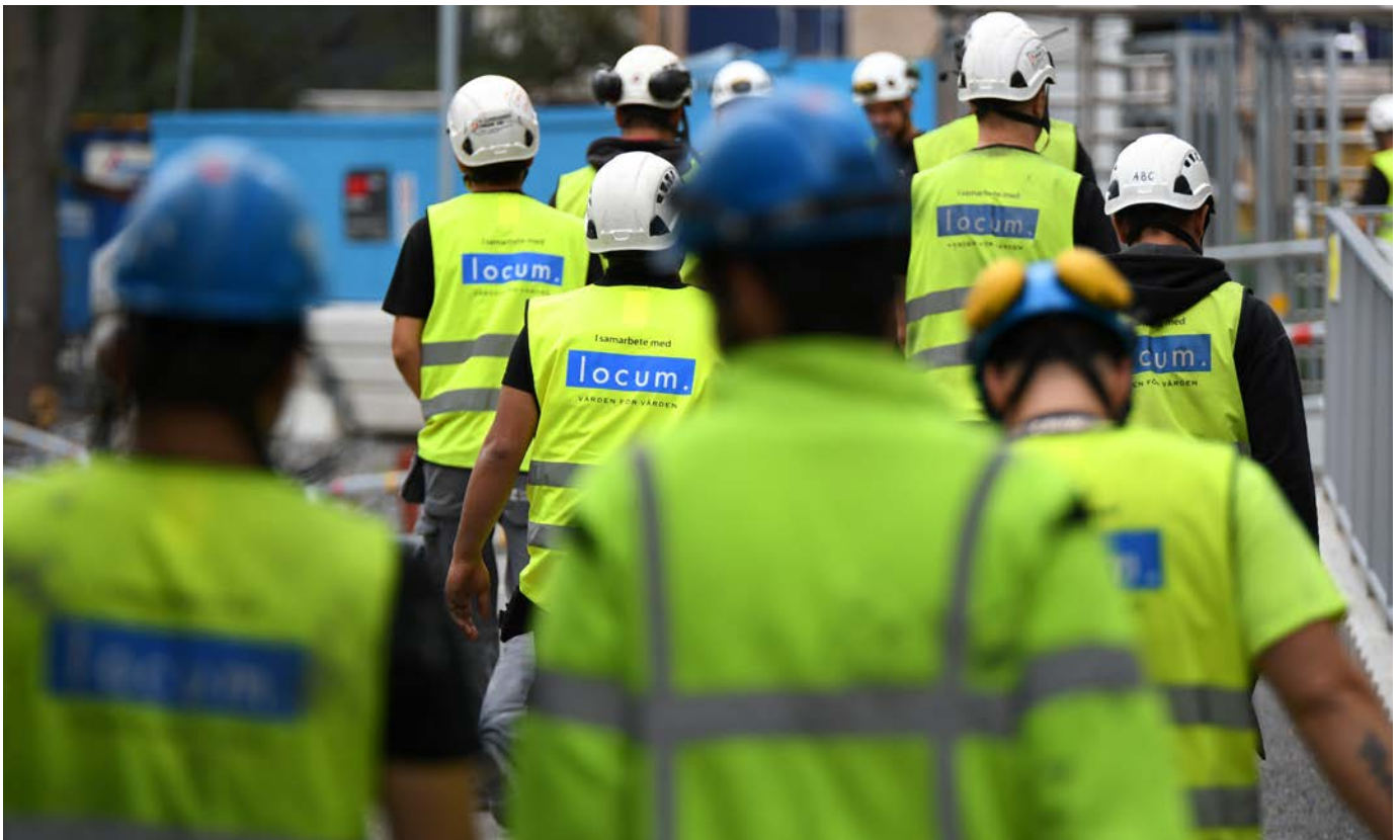
Ovan: Byggarbetsplats på Danderyds sjukhus.
