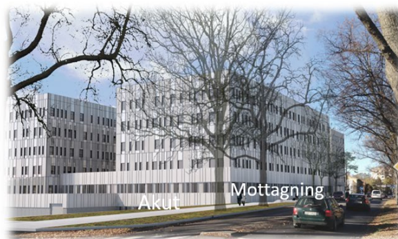
Södertälje hus 20 med en påbyggnad 4 plan
