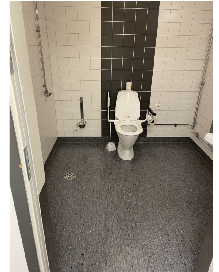
Ett fåtal WC-rum är i gott skick men har gamla rör
