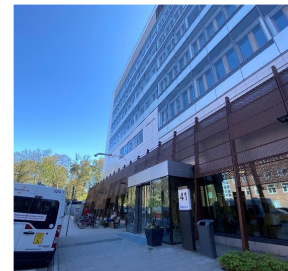
figur 7:9. Befintlig byggnad U290, entré mot norr där nybyggnation L9 planeras att ansluta. Bilden visar även klinkerfasad. Yttre fasad av kortén som mellan L7 och U290 kommer att demonteras.
