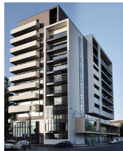
BALKONGER BETONAR GAVLARN
